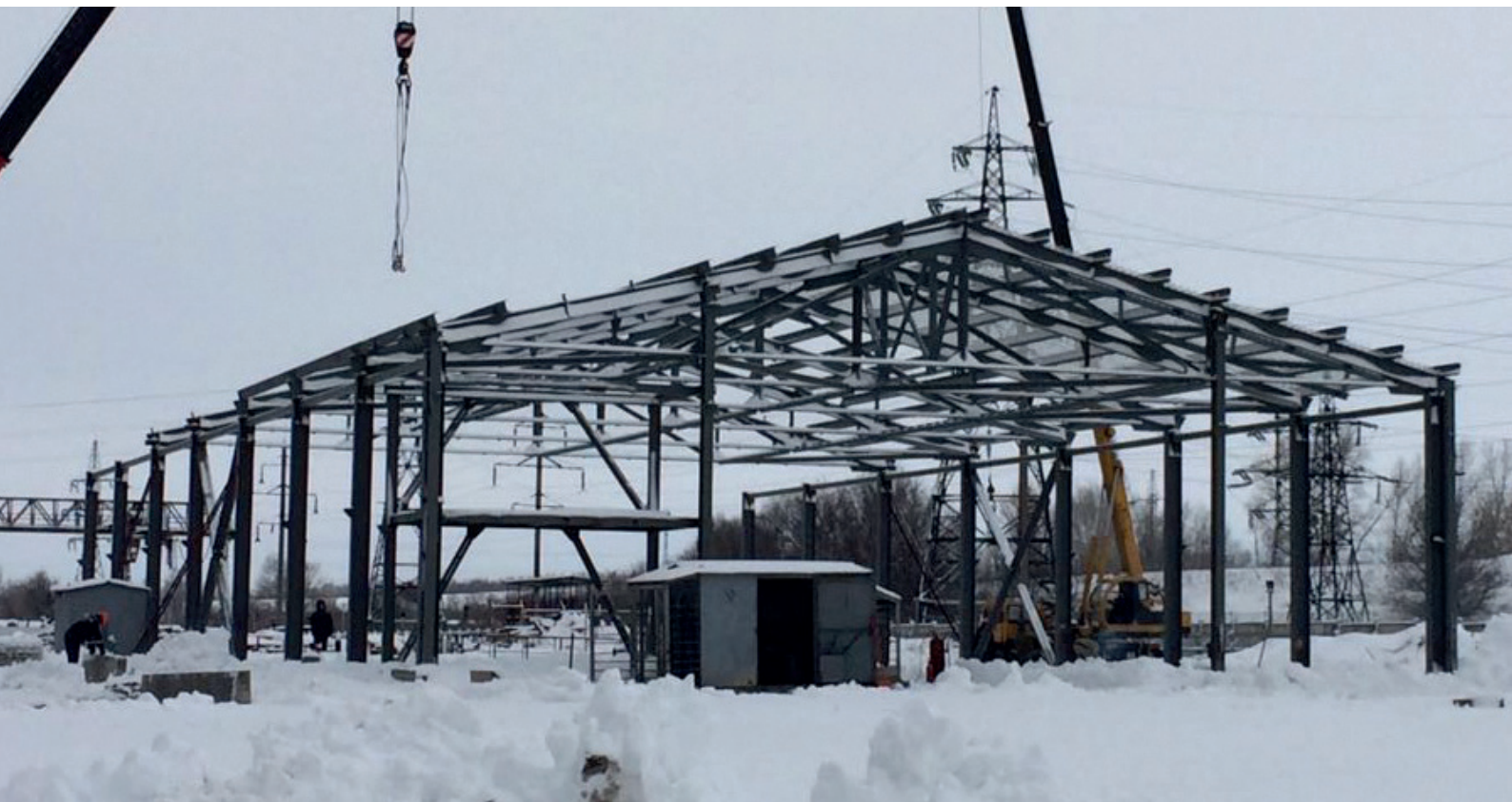
Строительство Склада НОУ МАГАТЭ на Ульяновском металлургическом заводе в Усть-Каменогорске, 2017 год.
